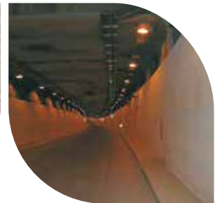
CIRCONVALLAZIONE NORD TUNNEL LINING ROME ITALY
